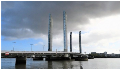
アキテヌ橋 昇降式可動橋
